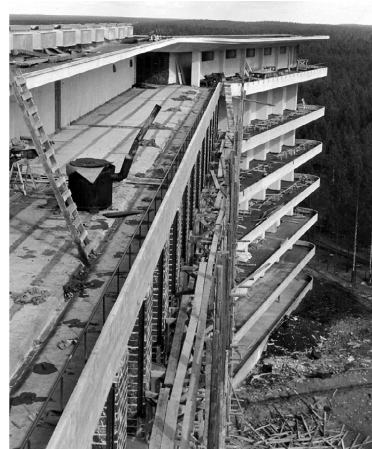
The Paimio construction site (AAM 50-003-079).
