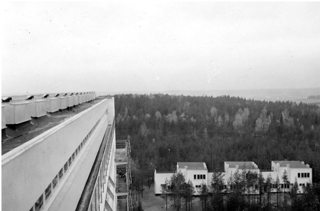
Painovoimaisen ilmanvaihdon alkuperäiset poistopiiput potilassiiven vesikatolla (kuva: AAM 50-003-442).
